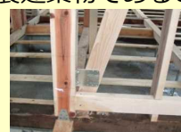
耐震補強工事の例
