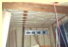
外壁断熱工事の例
