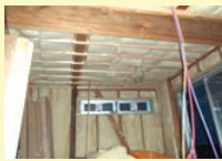
外壁断熱工事の例
