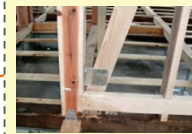
耐震補強工事の例
