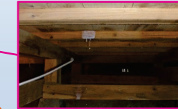
【劣化対策】防腐防蟻処理
