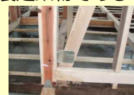
耐震補強工事の例
