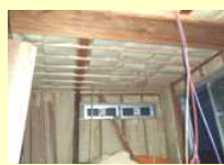
外壁断熱工事の例
